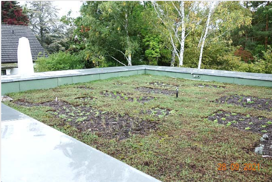
Begrünung von Dachflächen bei Pflegeeinrichtung in Berlin
