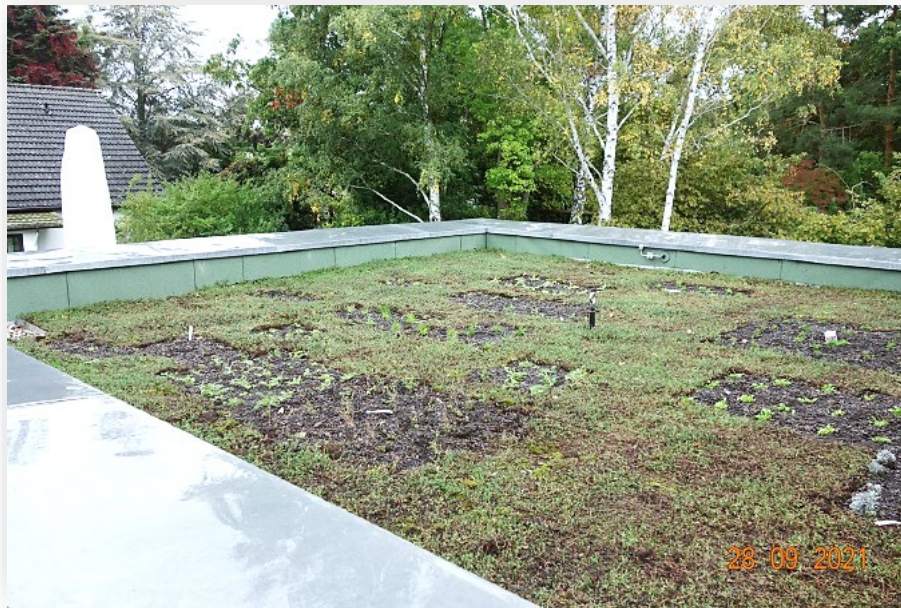
Begrünung von Dachflächen bei Pflegeeinrichtung in Berlin
